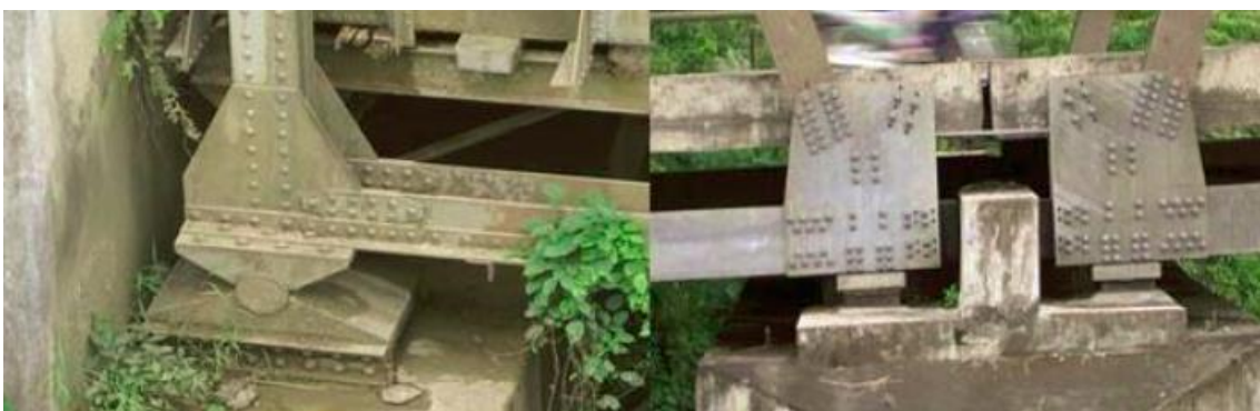
Gambar 4.4. Aplikasi tumpuan sendi pada struktur jembatan
